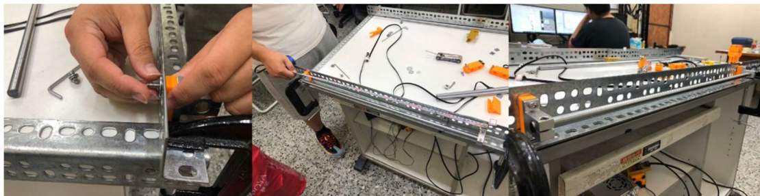
圖 3. 113 Y 方向光軸架設
